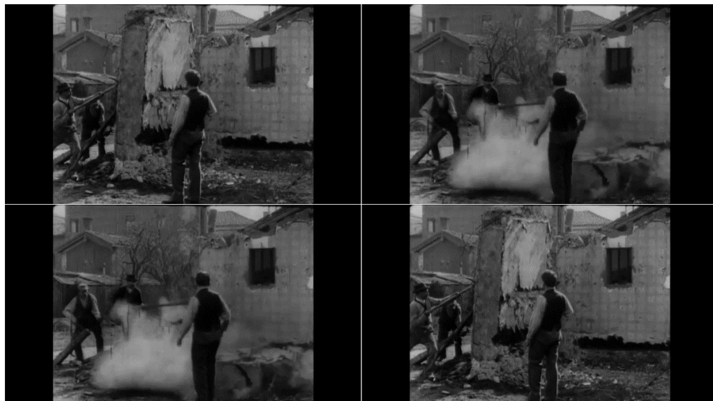
Fig. 4 Demolition d'un mur , 0"27-1"01 (v. nota 54)
